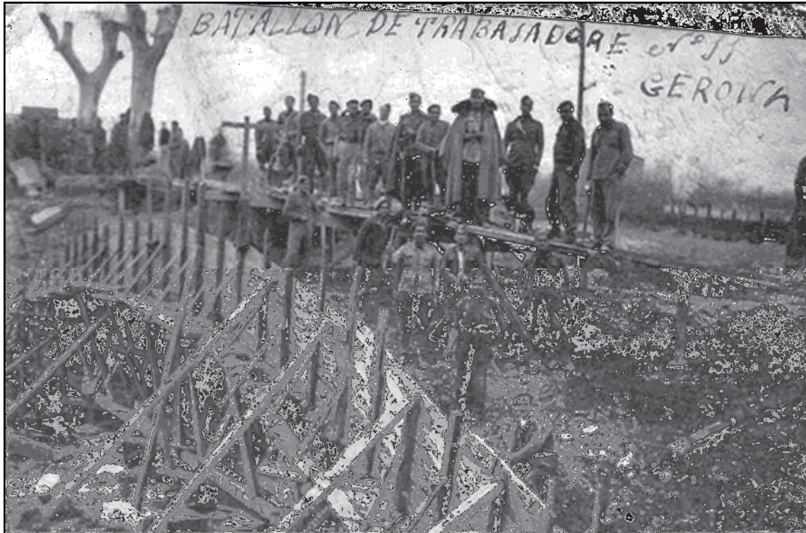
Presos republicanos y antifranquistas del 11º BDST Gerona, construyendo un puente en 1941.
