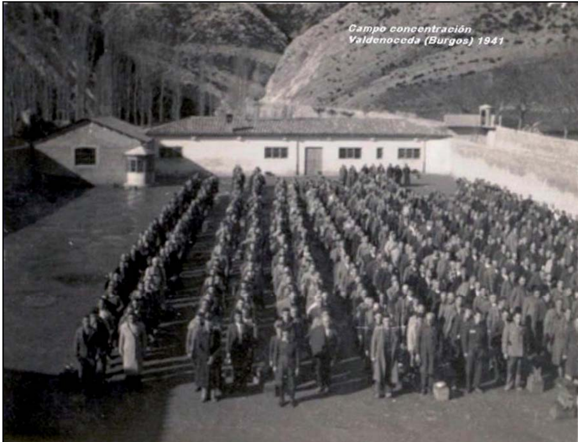
Presos republicanos de Valdenoceda se disponen a partir de esta Prisión Central en Burgos, tras ser asignados al Destacamento Penal de Pedrosa de Valdeporres para la construcción del ferrocarril Santander-Mediterráneo y el túnel de La Engaña.
